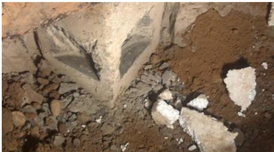
Рис. 2. Площадки в теле сваи
